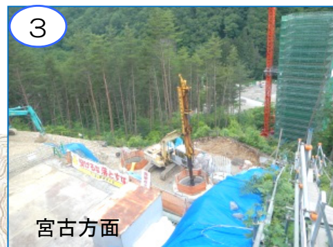
2 (仮称) 摂待大橋のA1橋台(宮古側)の基礎となる深礎杭を施工中です。
