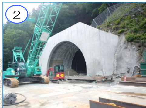
1 (仮称) 摂待第2トンネルの掘削は6月26日現在、南側・北側合計で1,445m(81%)の進捗です。トンネル南側坑口部では(仮称) 摂待大橋のA2橋台の土留め工を施工中です
