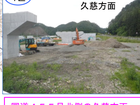
6 国道455号北側の久慈方面流入路(ランプ)の地盤改良・盛土工事の準備中です。
