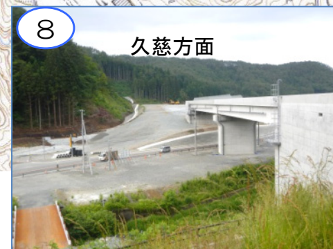
8 国道45号に接続する(仮称) 岩泉南インターチェンジの盛土工事を施工中です。
