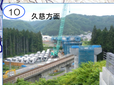
10 (仮称) 新小本大橋は、小本川を渡る橋桁が架かりました。引き続き、宮古側の三陸鉄道を跨ぐ部分について、橋桁を掛ける準備を進めています。
