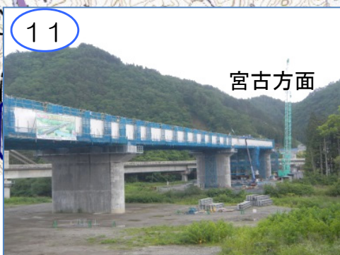
10 (仮称) 新小本大橋は、小本川を渡る橋桁が架かりました。引き続き、宮古側の三陸鉄道を跨ぐ部分について、橋桁を掛ける準備を進めています。
