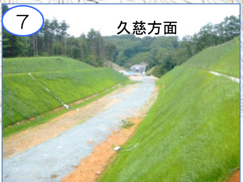
7 切土区間の仕上げ状況です。写真奥は(仮称) 摂待第1トンネルの宮古側坑口です。
