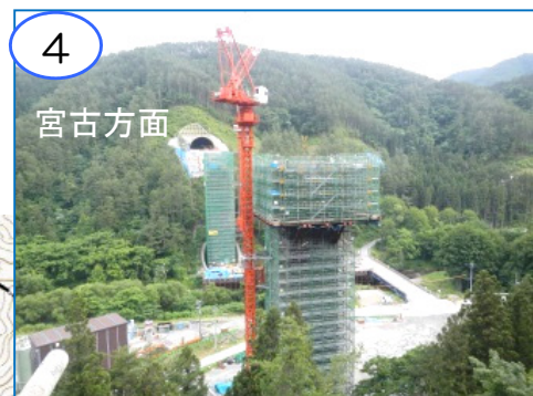
3 (仮称) 摂待大橋のP2橋脚(高さ42m)が完成し、上部工(橋桁を架ける)柱頭部の施工を進めています。
