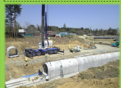
函渠設置工事の状況
