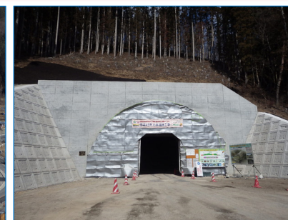
新小本トンネル(宮古側坑口)
