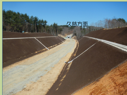
切土工事区間
