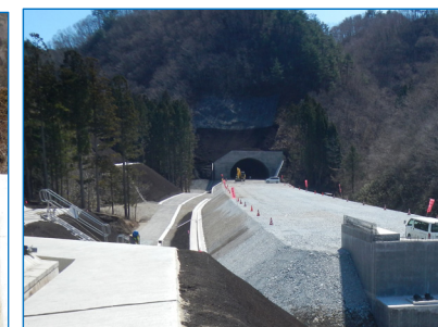
新小本トンネル(久慈側坑口・盛土工区間)
