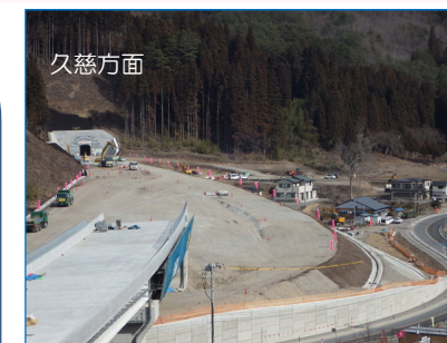
小成地区(盛土工区間)
