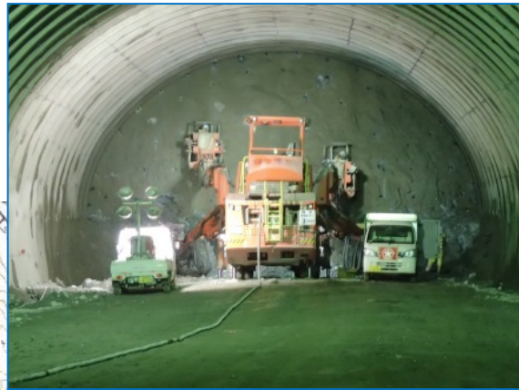
② 摂待道路工事 施工:大成・銭高・東コン 特定JV
