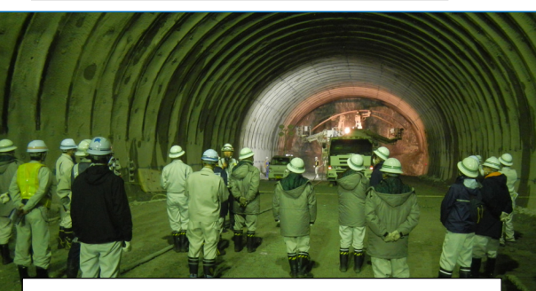
摂待第2トンネル：切羽施工の安全管理について
