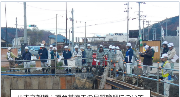
小本高架橋：橋台基礎工の品質管理について
