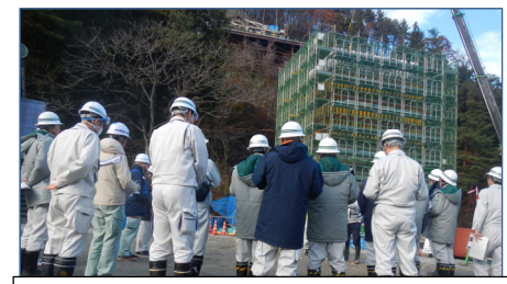
摂待大橋：高さ50m橋脚の施工方法について
