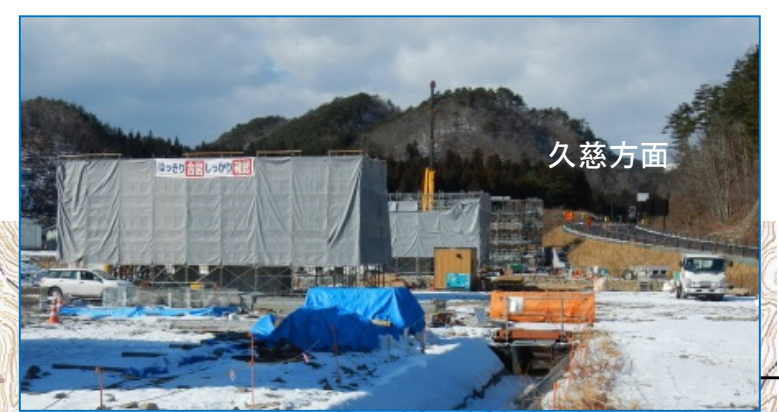
⑤ 岩泉地区道路工事 施工:東亜建設工業(株)
