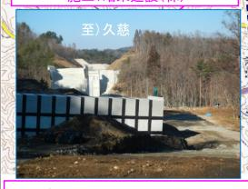
本線盛土箇所の軟弱な地盤の改良を終えています。三陸道路の両側(山側と海側)を 結ぶ通路の函渠も概ね出来ています。 第1TN西坑口まで の掘削完了です
