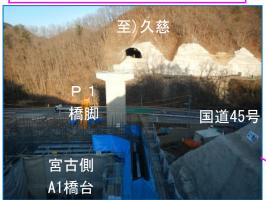
国道を跨ぐ(仮称)新柳渕橋のP1橋脚は完了しました。引き続きA1橋台を造る工事を進めています。
