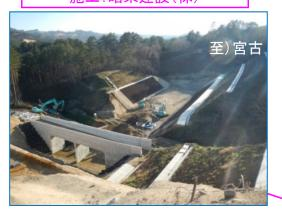
切土のり面保護として、種子入り吹付け工など仕上げ作業を進めています。
