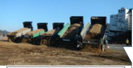
この土砂は、 普代道路起点 部付近の三陸 沿岸道路工事 現場から片道 約19kmを運 搬しています。
