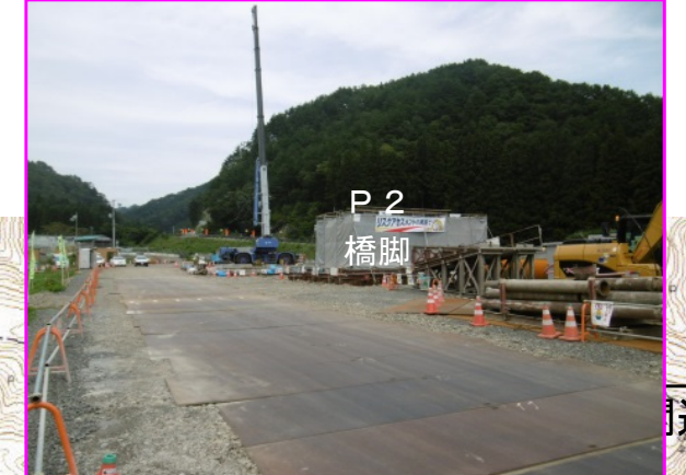
⑤ 岩泉地区道路工事 施工:東亜建設工業(株)
