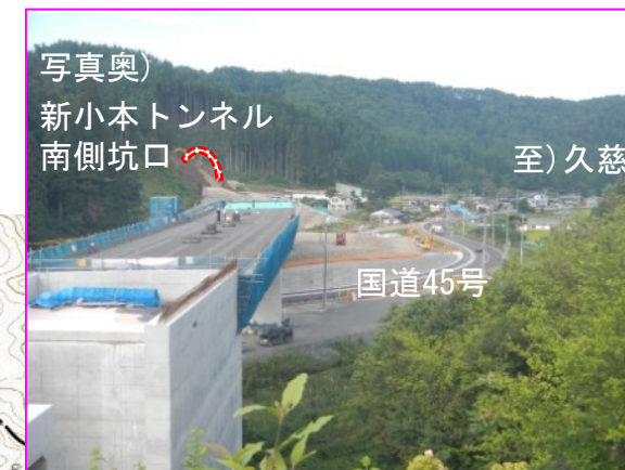
④ 新小本大橋上部工工事 施工:(株)東京鉄骨橋梁
