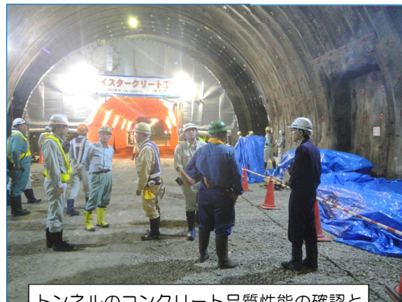
トンネルのコンクリート品質性能の確認と質疑の状況です。
