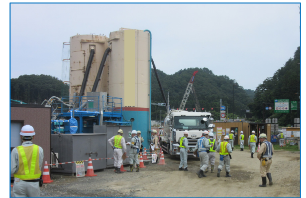
不安全な設備や行動等を点検確認しています。
