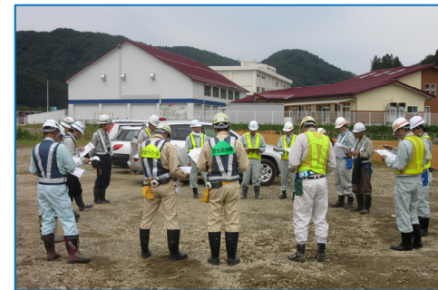
パトロール前の打合せ状況 (作業体制, 使用機械, 安全注意事項等の確認を行っています)
