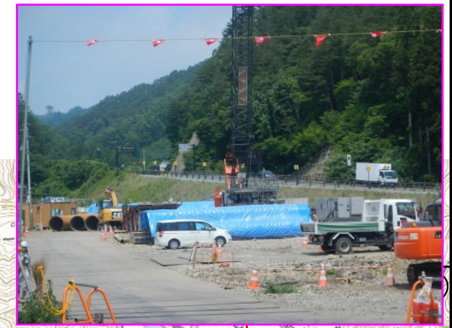
⑤岩泉地区道路工事 施工:東亜建設工業(株)
