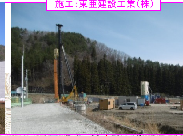
⑥ 岩泉地区道路工事 施工:東亜建設工業(株)
