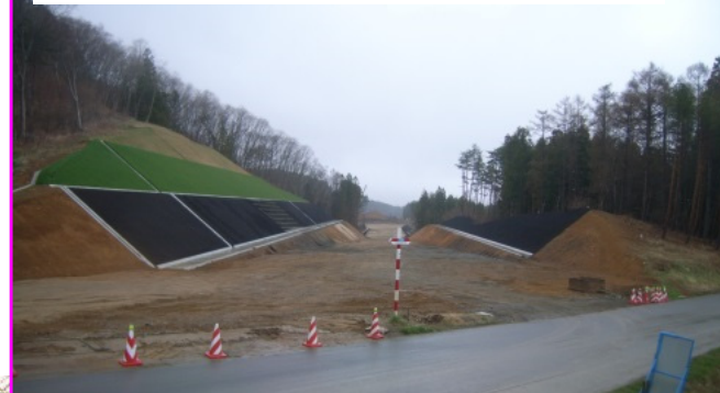
菅窪南地区道路改良工事:「3/20完了」
