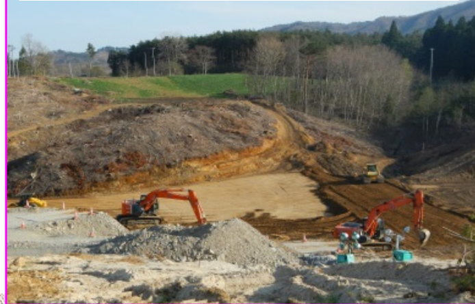
①大芦南地区道路改良工事 施工:(株)森本組
