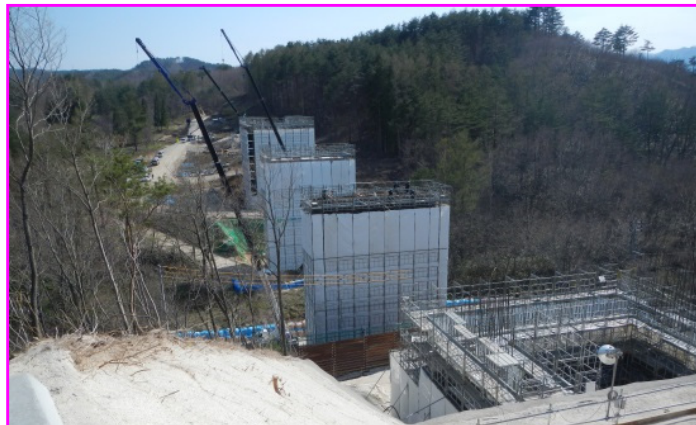
②新一の渡橋下部工工事 施工:(株)森本組
