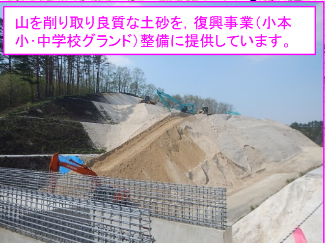
⑧沼袋北地区道路改良工事 施工:昭栄建設(株)
