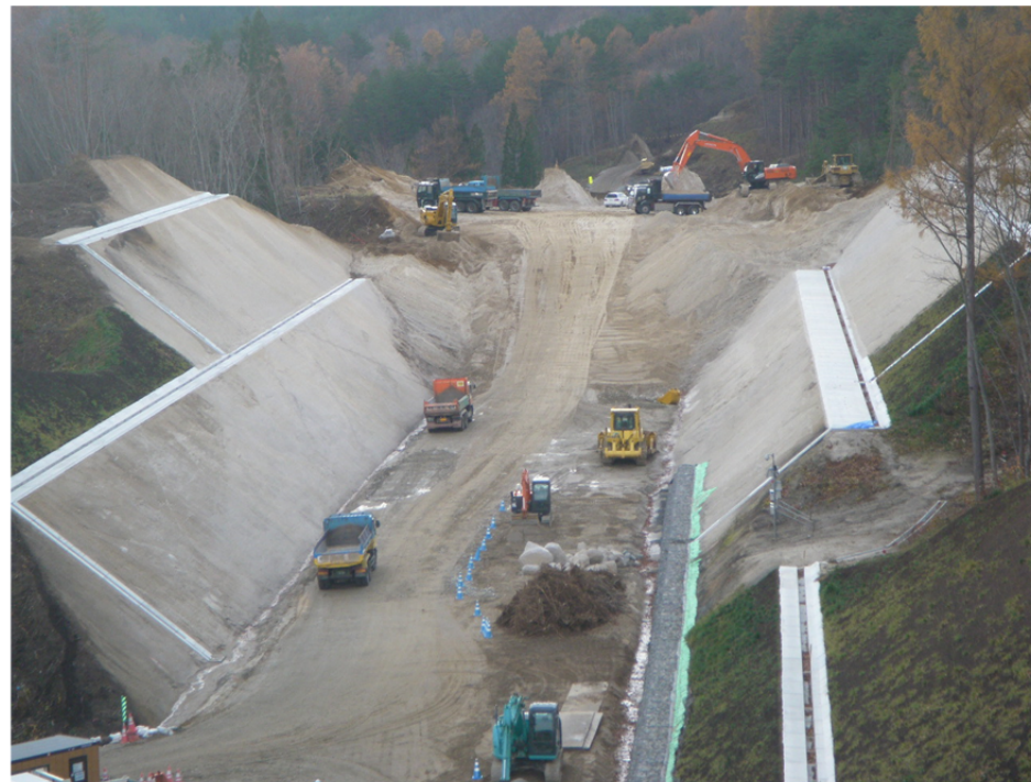
▲現場の全景です
