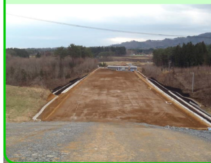
盛土箇所客土吹付状況
