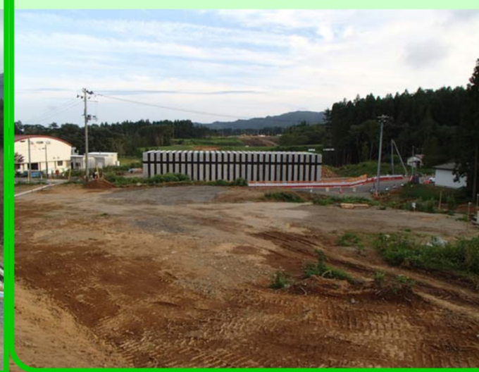
ボックスカルバート設置完了
