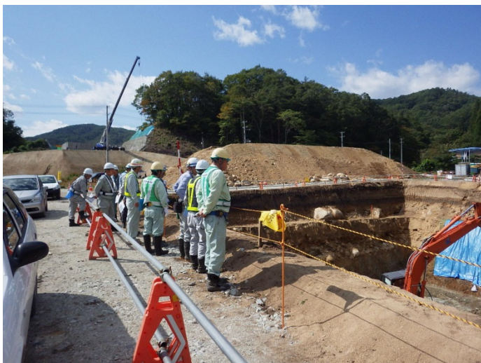
協議会で現場を安全パトロール
