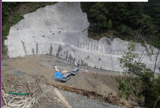
① 摂待地区道路改良工事 施工(株)ノバック
