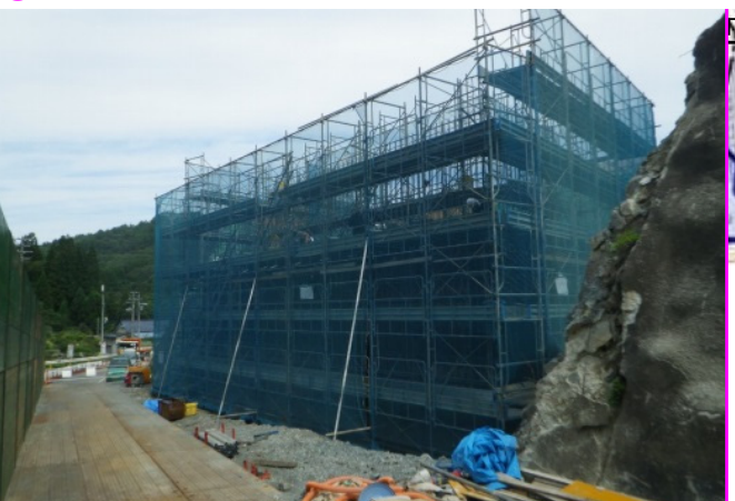
③ 下摂待地区道路改良工事 施工:三好建設(株)
