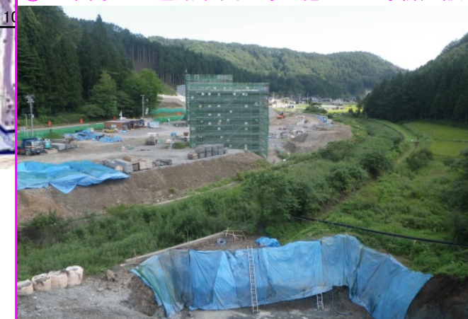
④ 小本南地区道路改良工事 施工:小野新建設(株)
