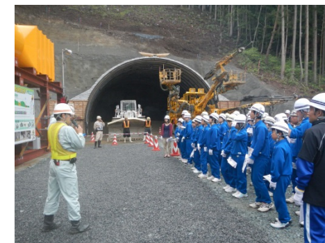
小本トンネル坑口での説明
