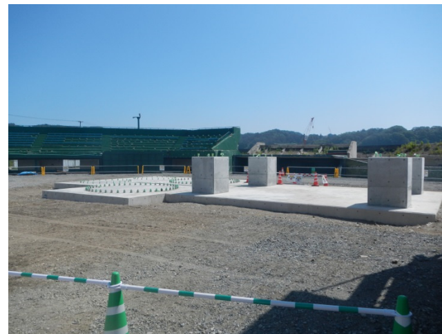
プラント設備の基礎部
