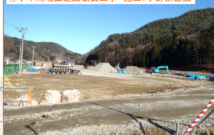
④ 小本南地区道路改良工事 施工:小野新建設
