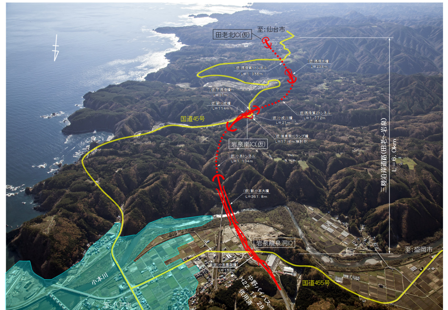
田老岩泉道路全景(平成25年11月撮影)
