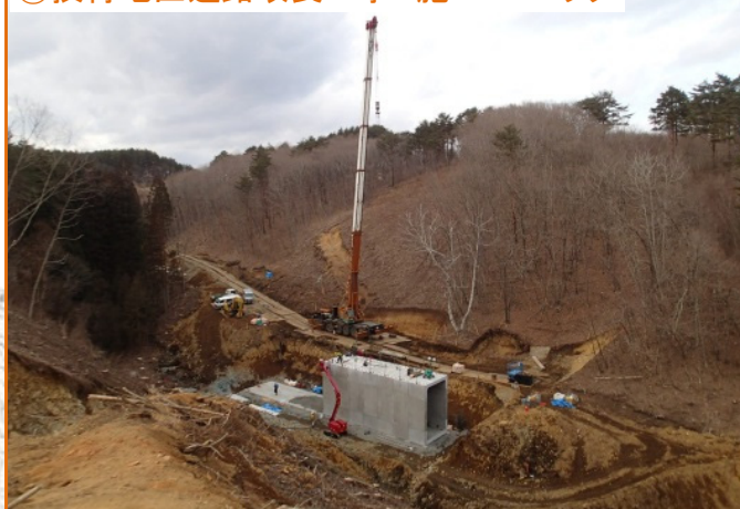
① 摂待地区道路改良工事 施工:ノバック
