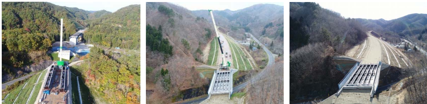
〔H30.10〕 橋桁の地組作業状況 〔H30.11〕 橋桁の架設状況 〔H31.1〕 橋桁架設（完成）
