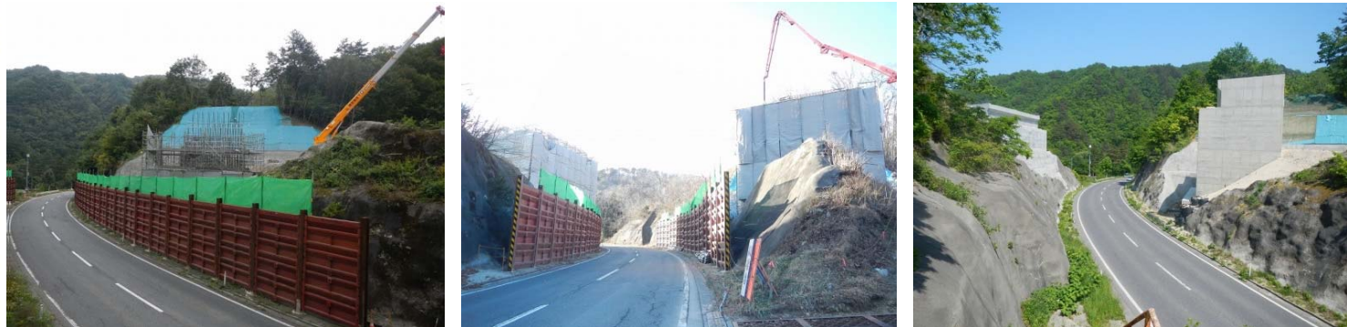
〔H26.10〕 宮古側・橋台の工事状況 〔H26.12〕 久慈側・橋台の工事状況 〔H27.6〕 橋台完成
