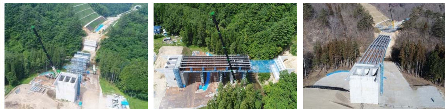
〔H30.7〕 ベント設備の設置状況 (ベント設備：橋桁の架設中に桁を支える設備) 〔H30.8〕 クレーンベント工法による橋桁の架設状況 〔H31.1〕 橋桁架設（完成）
