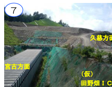
(菅窪工区) 土工事の準備中です。
