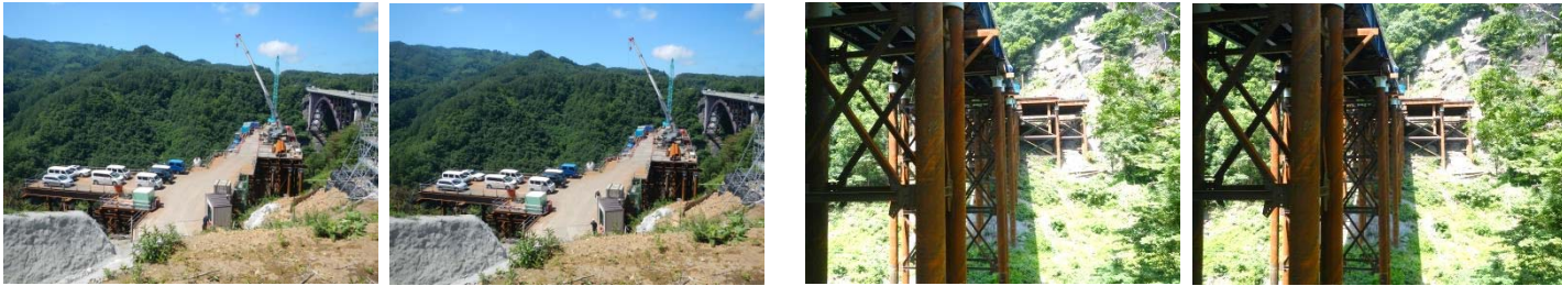
新思惟大橋南側の工事状況です。
