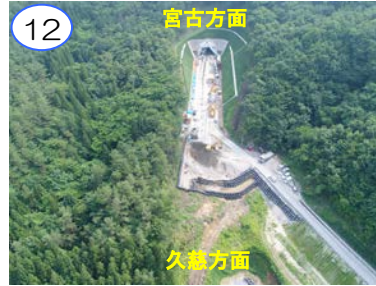
トンネル掘削中です。
