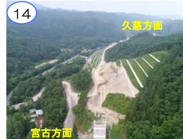
土工事中です。
