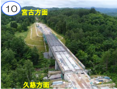
鉄筋組立中です。
