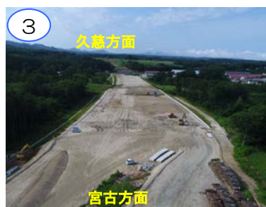
(大芦工区) 排水構造物作業中です。
