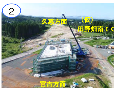
型枠解体中です。
