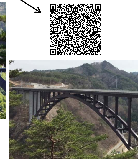
春から奥の工事用道路が始まりました。
