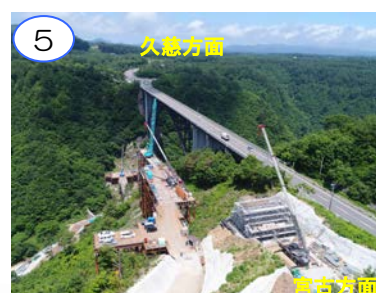
橋台と仮栈橋作業中です。
