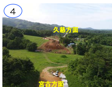
土工事中です。
