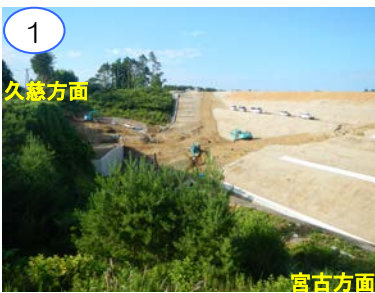
排水構造物整備中です。
