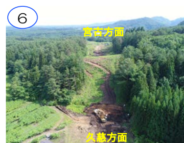
土工事中です。
