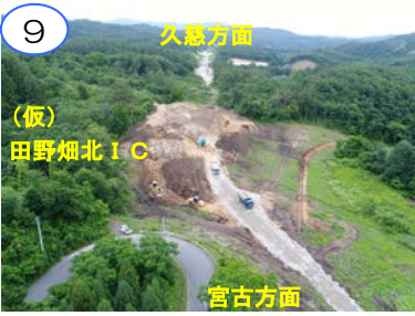
土工事中です。
