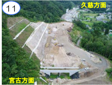
トンネルと岩山を掘削中です。
