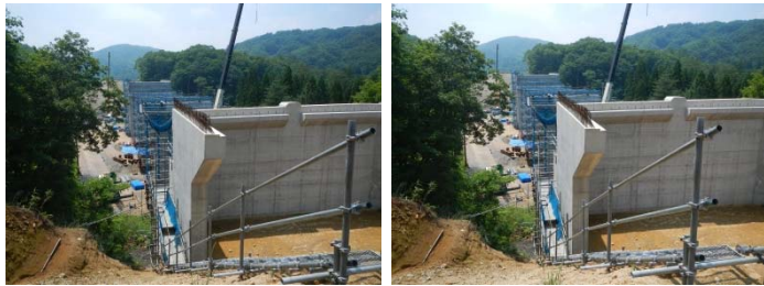
芦渡橋北側橋台で足場を単管で組み立て中です。
