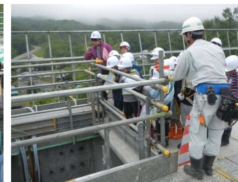
完成後には見られない内部構造
