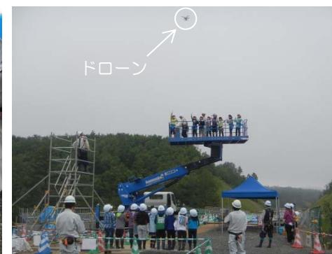
高所作業車の上空から記念撮影
