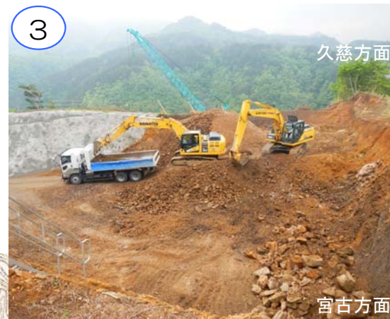
新思惟大橋の橋台・橋脚工事に取り掛かります。
