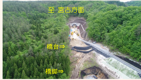
普代川大橋（橋台・橋脚）工事を行います。
