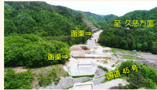
函渠工事を行います。
