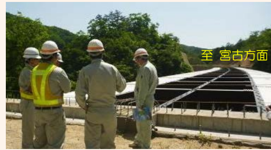
新柳瀨橋の床版工事を行います。
