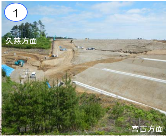
田野畑ICの掘削を行っています。 土は、田野畑南ICで盛土として利用しています。
