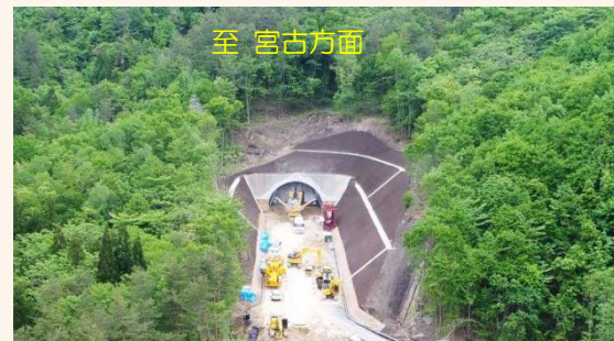
北側から、トンネルの掘削を行います。
