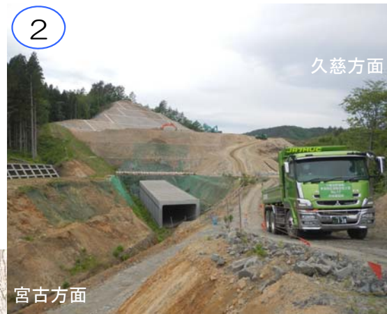
田野畑ICの掘削を行っています。 土は、田野畑南ICで盛土として利用しています。
