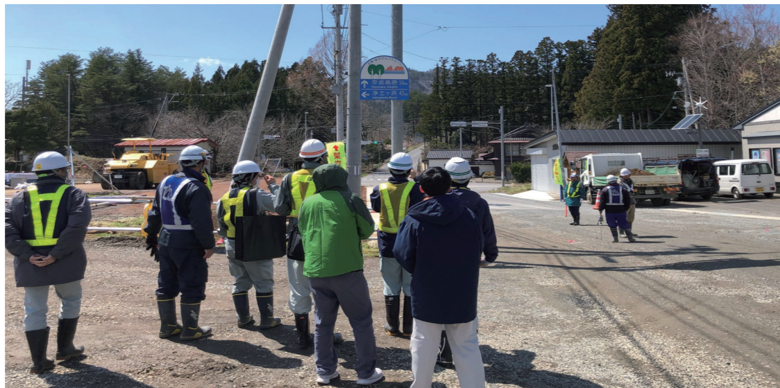
▲関係機関協議の様子(立会)
