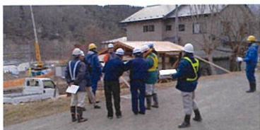
▲関係機関協議の様子(立会)
