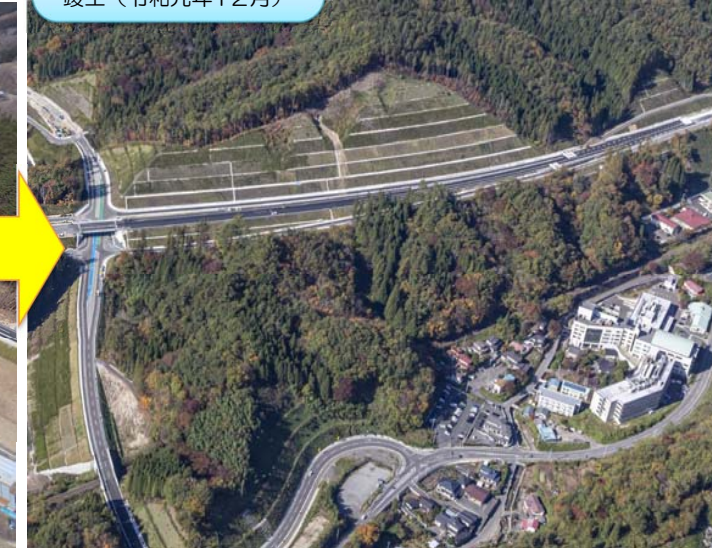
竣工（令和元年12月）
