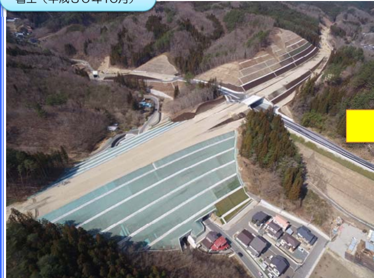
着工（平成30年10月）
