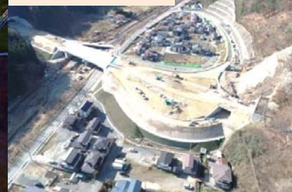
施工：⑩大坂建設
