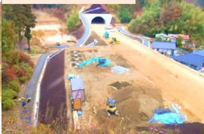
施工：④不動テトラ
