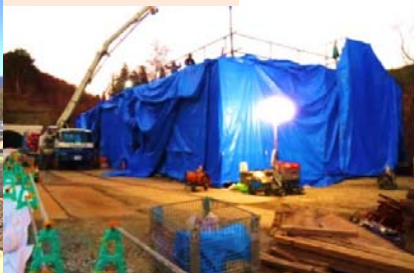
施工：⑤菊地建設
