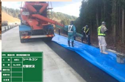
施工：⑨フジタ道路
