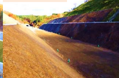
施工：⑧榎下建設
