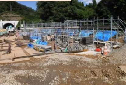
施工：⑤菊地建設
