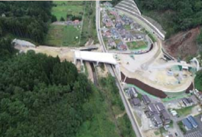
施工：⑩大坂建設
