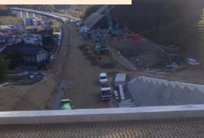
施工：④不動テトラ
