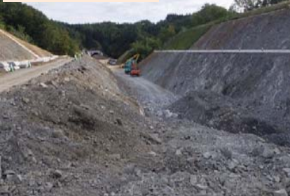
施工：⑧樋下建設
