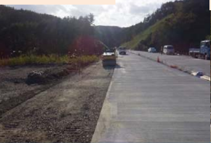
施工：⑨フジタ道路
