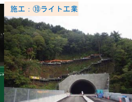
施工：⑩ライト工業 崎山第1トンネル～田老第5トンネルにかけて落石防護柵設置工事をすすめています。
