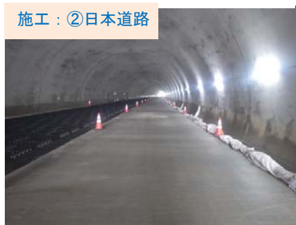
施工：②日本道路 宮古中央IC～宮古北ICで舗装工事をすすめています。
