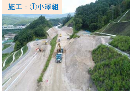
施工：①小澤組 千徳地区で土工事をすすめています。
