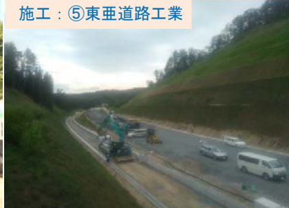
施工：⑤東亜道路工業 山口地区で舗装工事をすすめています。
