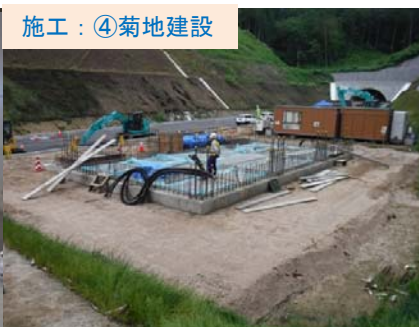
施工：④菊地建設 山口第1TN、山口第2TN付近の電気室工事をすすめています。
