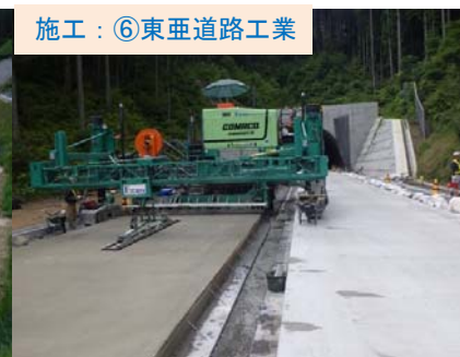
施工：⑥東亜道路工業 山口～崎山地区で舗装工事をすすめています。
