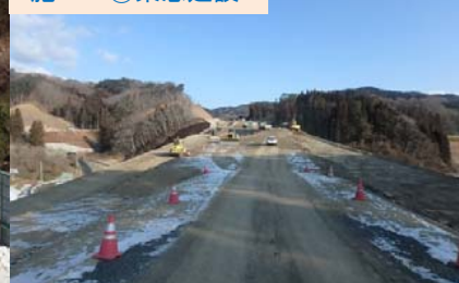
施工：⑤東急建設
