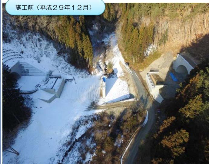
施工前(平成29年12月)
