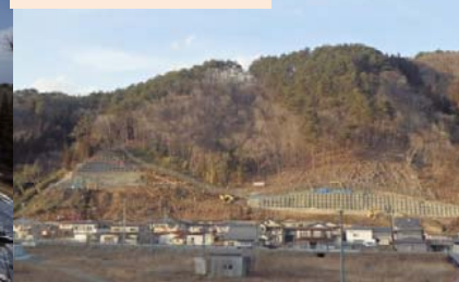
施工：⑧ライト工業
