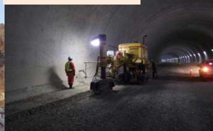
施工：⑩フジタ道路
