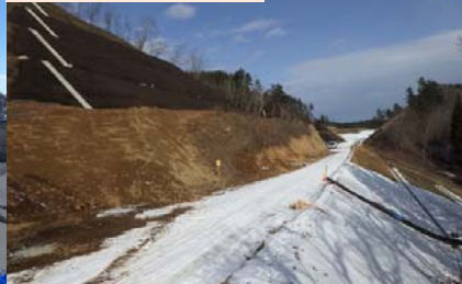
施工：⑥小澤組
