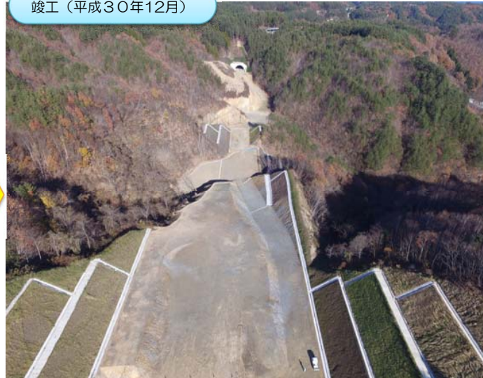
竣工(平成30年12月)
