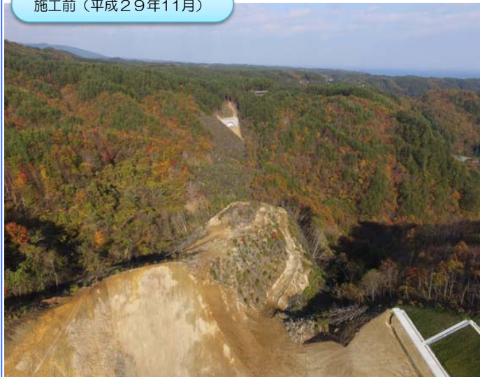
施工前(平成29年11月)
