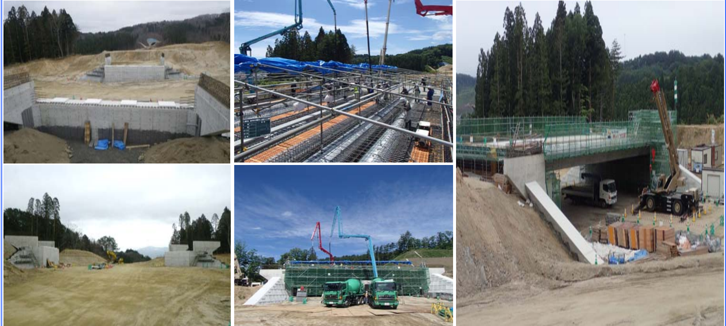
施工前状況 (H30.4月)
