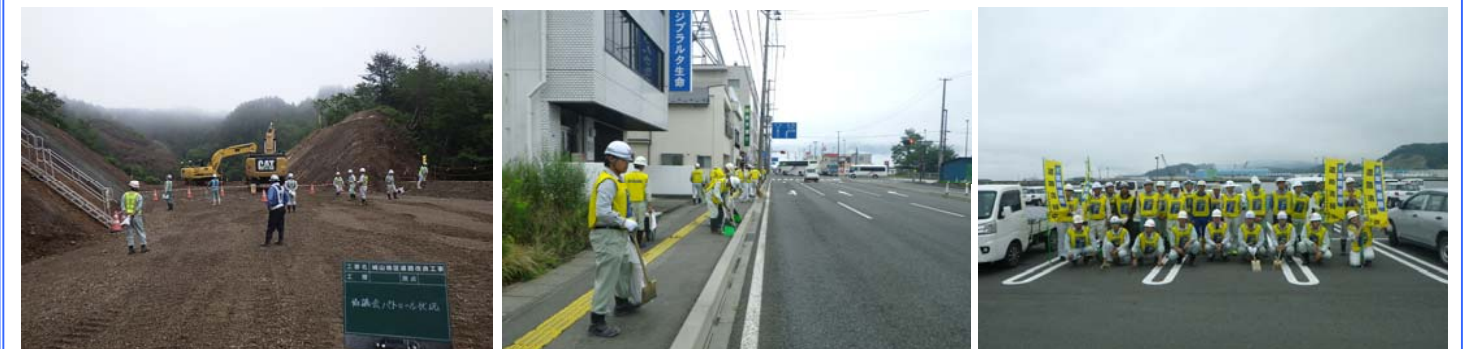
パトロールの様子 (崎山地区道路改良工事)
