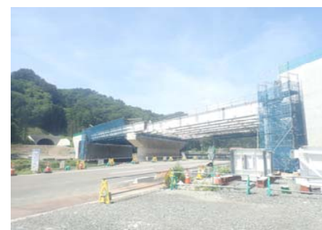
7月2日現在架設状況
