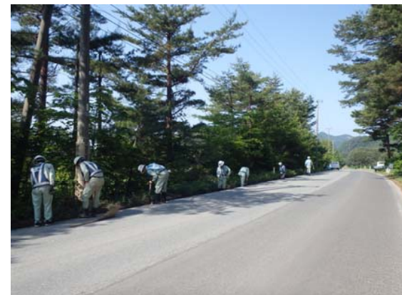
道路脇・側溝の土砂や雑草を取り除きました
