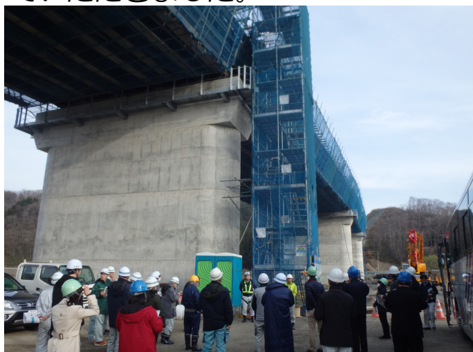
閉伊川橋の概要について説明
