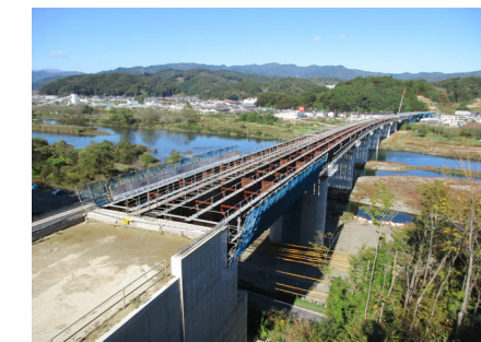
起点側より全景
