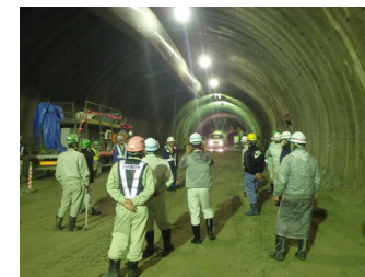
山口第1トンネルを見学
