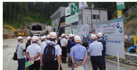
トンネル施工方法について説明
