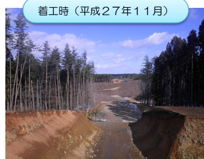
着工時(平成27年11月)
