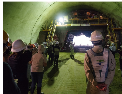
田老第5トンネル坑内を見学
