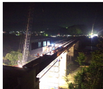
夜間架設の状況① 県道宮古港線
