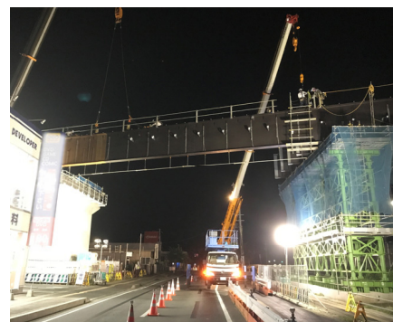
夜間架設の状況② 国道106号
