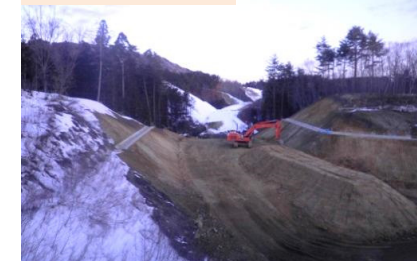
施工：⑬松尾建設
