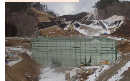
施工：⑪不動テトラ
