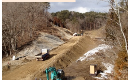
施工：④不動テトラ
