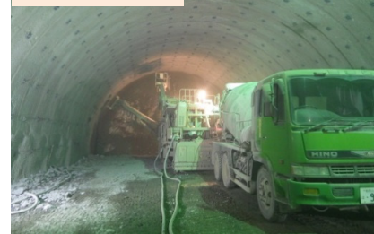
施工：⑨フジタ
