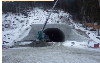
施工：⑥飛鳥建設
