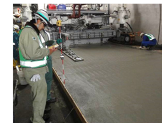
←←← トータルステーション（TS） 位置情報を施工器械に無線で 送信
