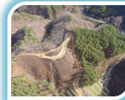
現場空撮（着工前）
