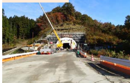
施工：⑥飛鳥建設
