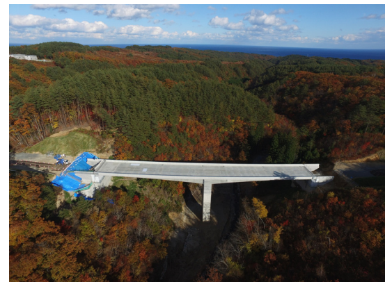
青の滝川橋全景
