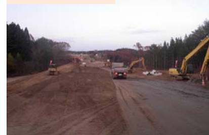
施工：⑮松尾建設
