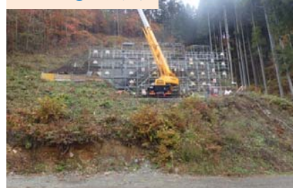
施工：⑩五洋建設
