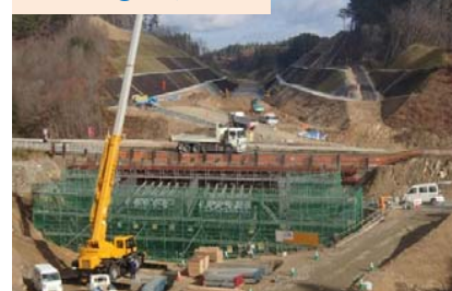
施工：⑫不動テトラ
