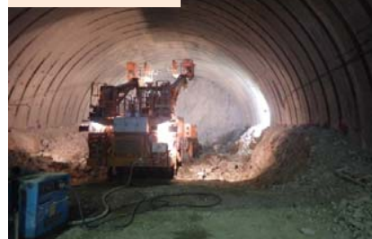
施工：⑨フジタ
