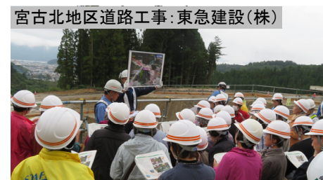
宮古北地区道路工事：東急建設(株)
