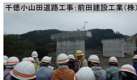
千徳小山田道路工事：前田建設工業(株)
