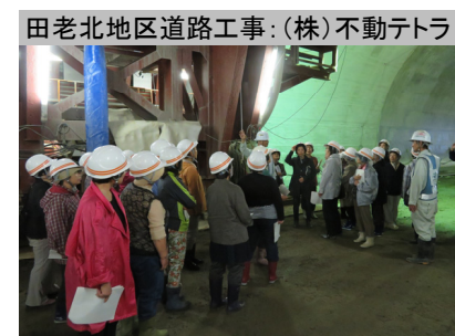
田老北地区道路工事：(株)不動テトラ 7月29日に貫通した田老第5トンネル
