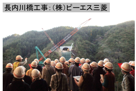
長内川橋工事：(株)ピーエス三菱 高さ50mの長内川橋を見学
