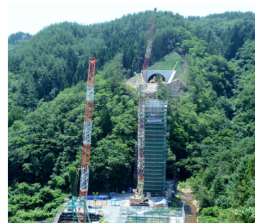
貫通点から南側の景色です。施工中の長内川橋(手前)と田老第4トンネル(奥)の工事現場が見えます
