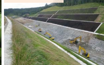
施工：⑩不動テトラ
