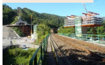
施工：⑥三井住友・日本国土JV
