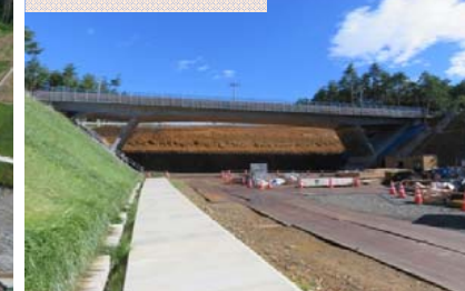
施工：⑫川田建設
