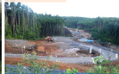
施工：⑪村本建設
