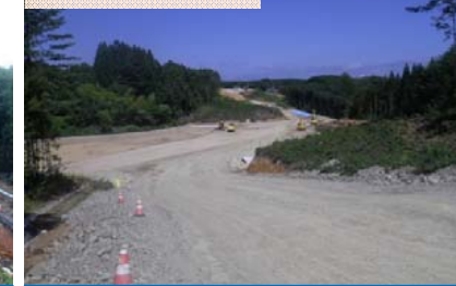
施工：⑬松尾建設
