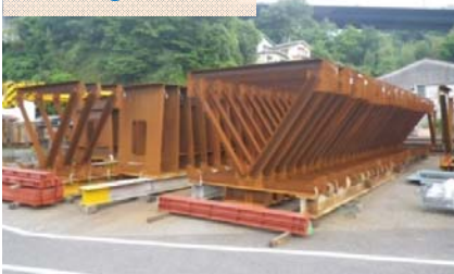
施工：②日立造船
