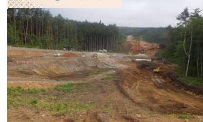
施工：⑪村本建設
