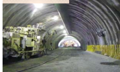
施工：④東急建設
