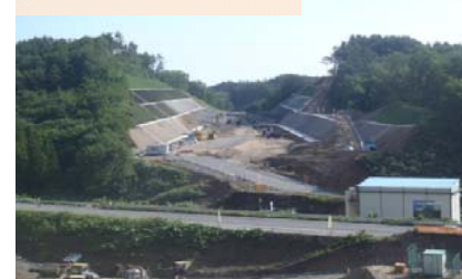
施工：⑩不動テトラ
