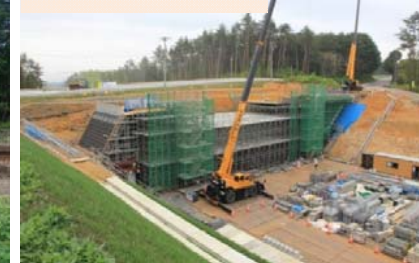
施工：⑪川田建設
