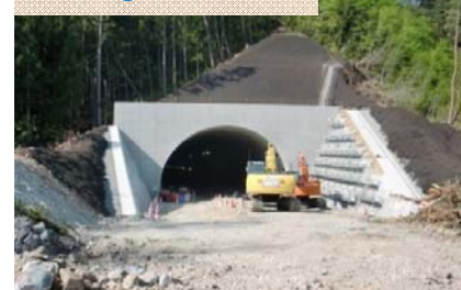
施工：⑦五洋建設
