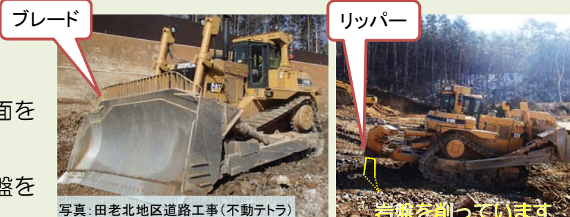
写真：田老北地区道路工事(不動アトラ)
