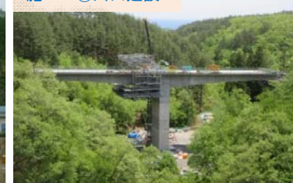
施工：⑪川田建設
