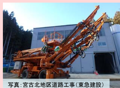
写真：宮古北地区道路工事(東急建設)
