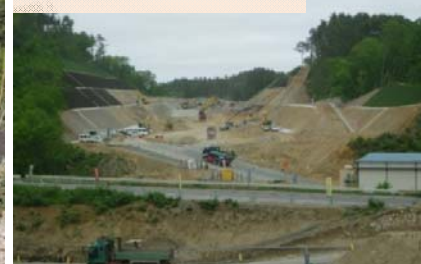
施工：⑨不動テトラ
