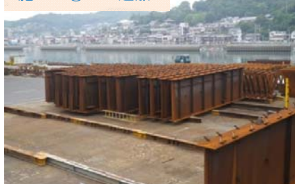
施工：②日立造船
