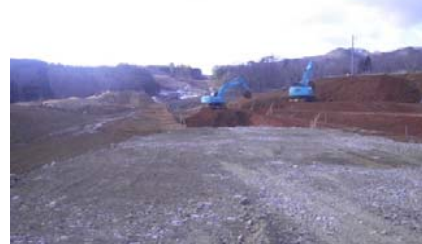
施工：⑭松尾建設
