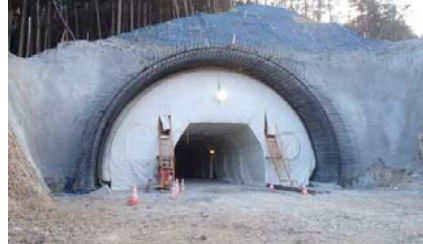
施工：⑦五洋建設
