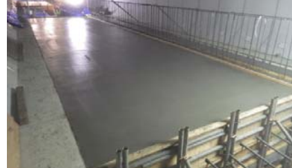
施工：⑫村本建設
