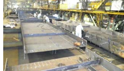
施工：②日立造船
