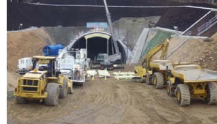
施工：⑨不動テトラ
