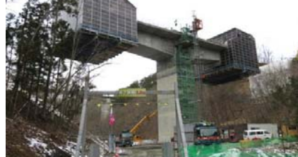
施工：⑬川田建設
