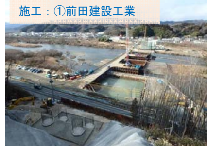
施工：①前田建設工業 手前に見える丸いものが、橋台(きょうだい)を支える杭です。
