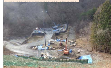
引き続き、長内川橋の杭工事を行 なっています。
