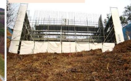
青野滝地区で、橋台(きょうだい) 工事を行なっています。
