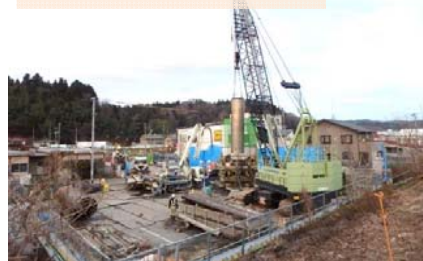
閉伊川橋の杭工事の状況です。
