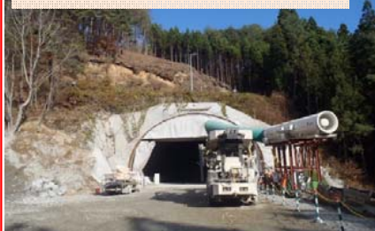
椋内第2トンネルの起点側です。 現在、起点側318m 終点側424m の進捗です。
