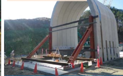
道路と水路になる、“アーチカル パート”の据付が始まりました。
