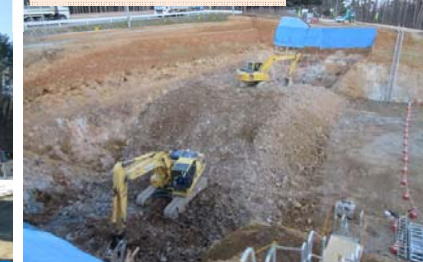
青野滝地区で、道路の上をまたぐ 橋の工事が始まりました。
