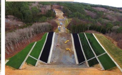
工事箇所全体写真です。 土を掘る作業は、9割終了しました。
