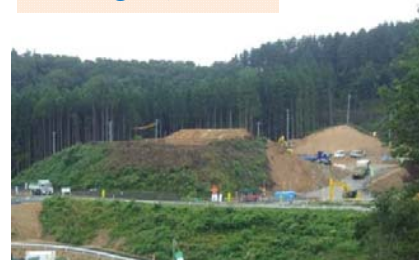
施工：⑨不動テトラ
