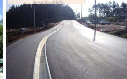
施工：⑮村本建設
