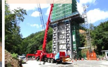
施工：⑬川田建設
