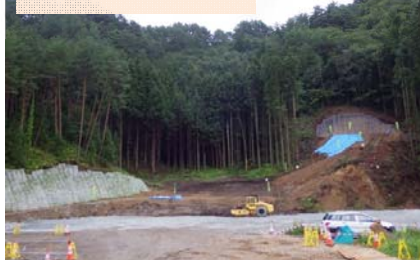
施工：⑦フジタ
