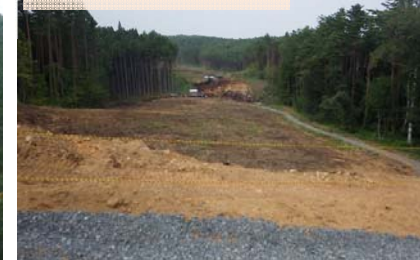
施工：⑪村本建設
