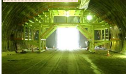
施工：③五洋建設
