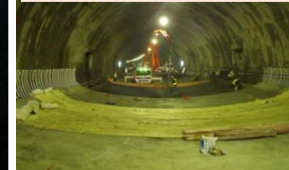
施工：①三井住友・日本国土JV
