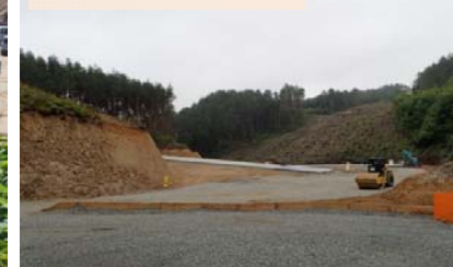
施工：⑥村本建設
