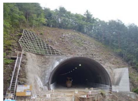
現在(6/18)の椋内第1トンネル (山田側から撮影)
