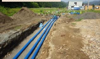
施工：⑨フジタ
