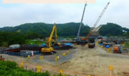
施工：④前田建設工業
