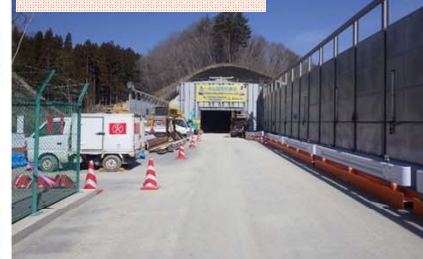
施工：②飛鳥建設
