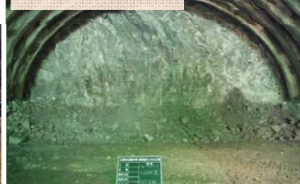
施工：③五洋建設
