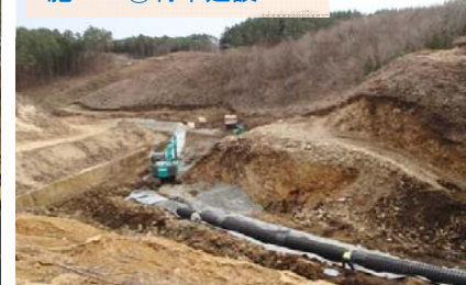
施工：⑥村本建設
