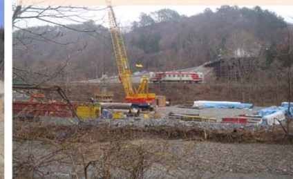
施工：①三井住友・日本国土JV
