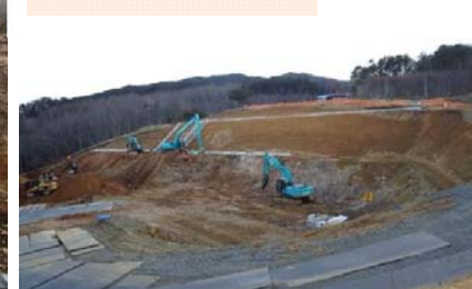
施工：⑨村本建設
