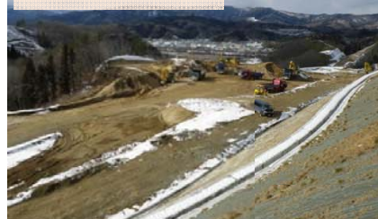
施工：⑩村本建設
