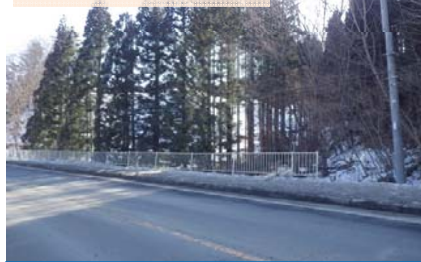
施工：⑭不動テトラ
