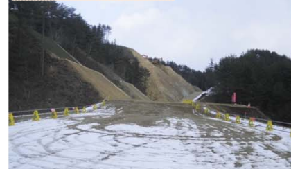
施工：⑬松尾建設
