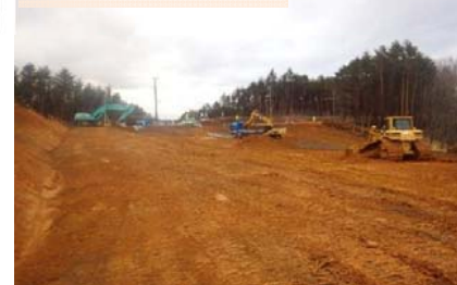
施工：⑪村本建設
