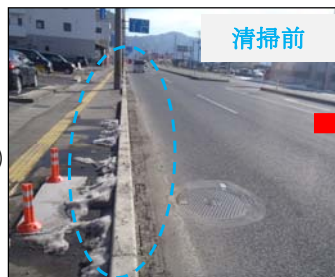
路肩の状態(小石の除去)
